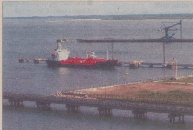
W gdańskim Porcie Północnym funkcjonuje Gdański Terminal Gazowy – Gaspol SA, w którym przeładunkuje się gaz LPG.
