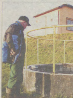
Roboty przy budowie kanalizacji w Majewie zakończą się w czerwcu.
