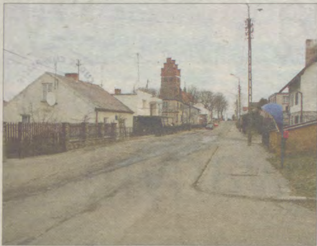
W Nowej Cerkwi zostanie wyremontowany chodnik.
