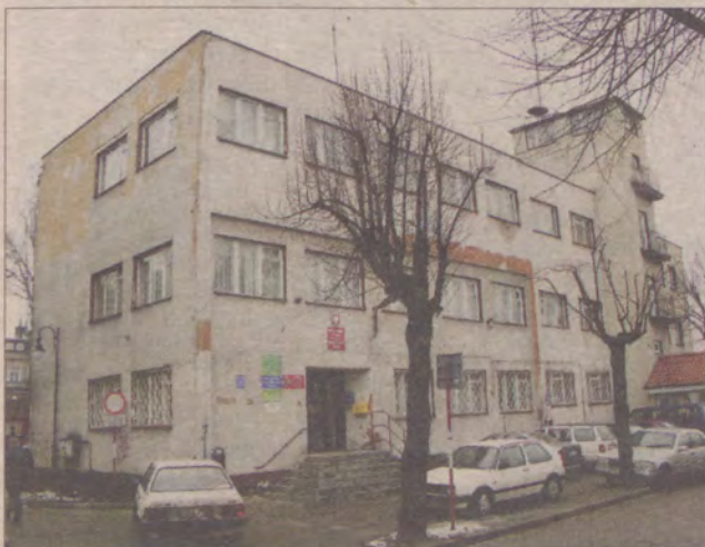
Już wkrótce budynek zostanie m.in. docieplony i nadbudowany.
