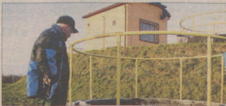
Kanalizacja w Majewie.
