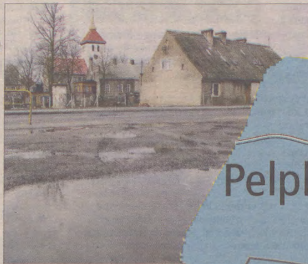
Kanalizacja w Rudnie.
