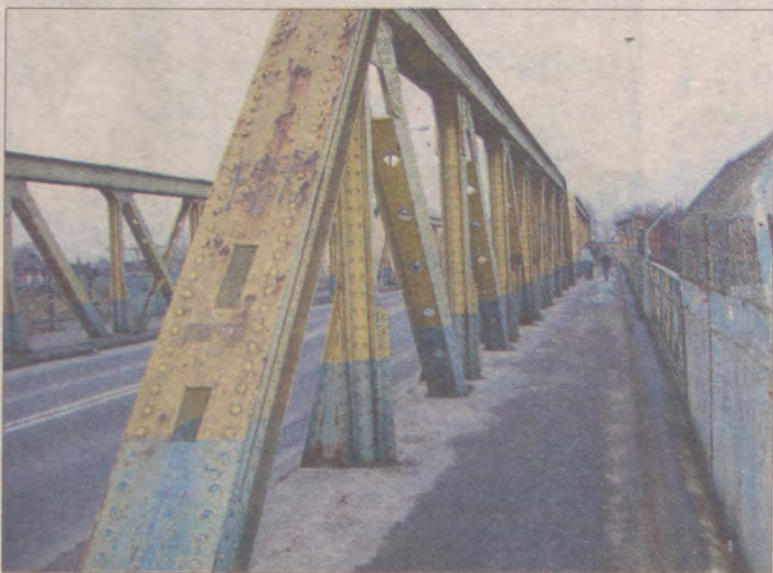
Wiadukt na ul. 1 Maja.
