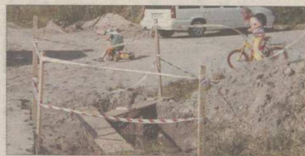
Dzieci z osiedla Rotmanka bawią się tuż obok placu budowy.
