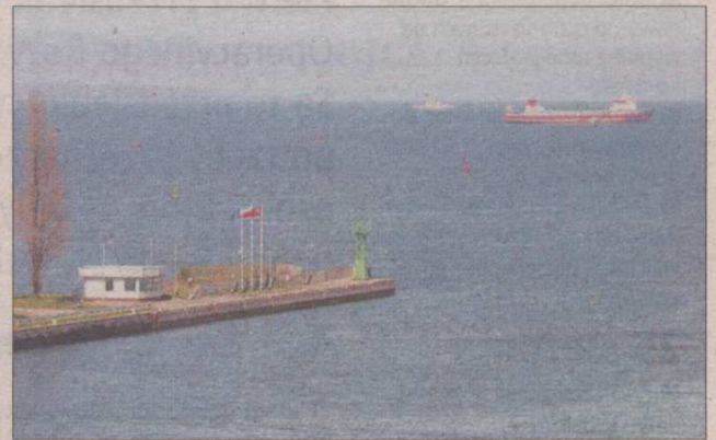
Po przebudowie wejście do wewnętrznego portu gdańskiego będzie miało szerokość 90 m.
