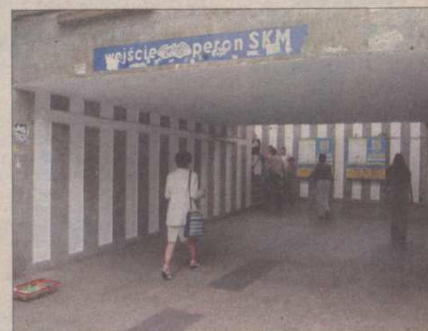
Tunel SKM przy ul. Chopina w Sopocie jest prawie gotowy.
