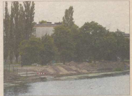
Remont brzegu Nowej Motławy.
