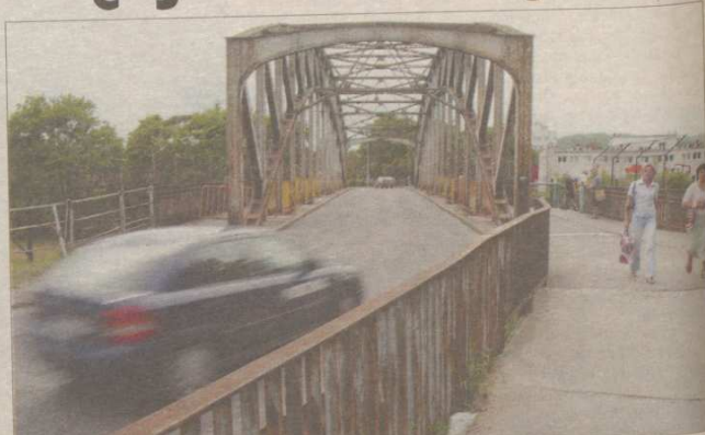
Po wiadukcie przy ul. Braci Lewoniewskich w Gdańsku mogą jeździć tylko samochody osobowe. W przyszłym roku, gdy zakończy się jego remont, nośność konstrukcji zostanie zwiększona do 50 ton.
