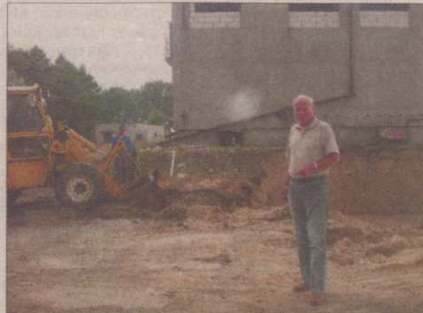
Remont oczyszczalni ścieków w Cedrach Wielkich rozpoczęły – pokazuje kierownik budowy Bernard Pawłowski.
