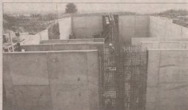
Prace przy budowie oczyszczalni prowadzone są w szybkim tempie.
