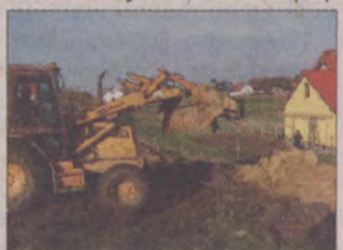
Trwają roboty ziemne.
