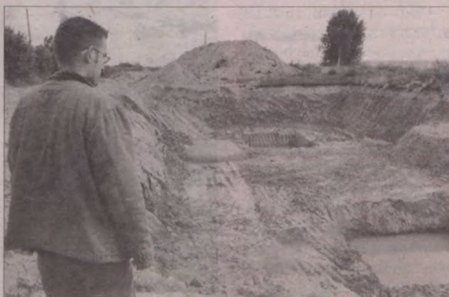
Budowa oczyszczalni traktowana jest przez władze gminy priorytetowo.
