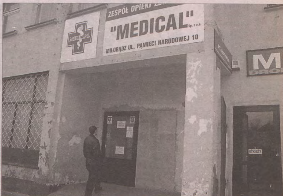
Budynek Medicalu w Miłobądku będzie wkrótce ocieplony.
