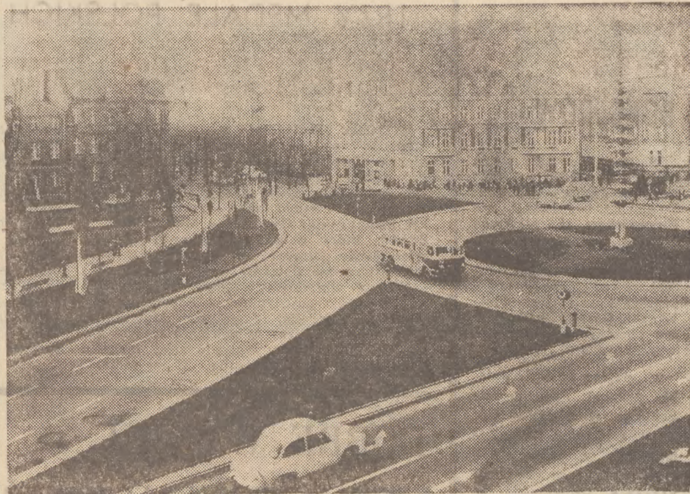
Centralny węzeł komunikacyjny w Słupsku, potocznie zwany przez kierowców rondem, wydatnie przyczynia się do usprawnienia ruchu w najbardziej nawralgicznej części miast a. Gdy niebawem zainstalowane zostaną tutaj urządzenia sygnalizacji świetlnej, „płynność ruchu pieszych i zmotoryzowanych użytkowników dróg będzie jeszcze wyjtkiewicz
