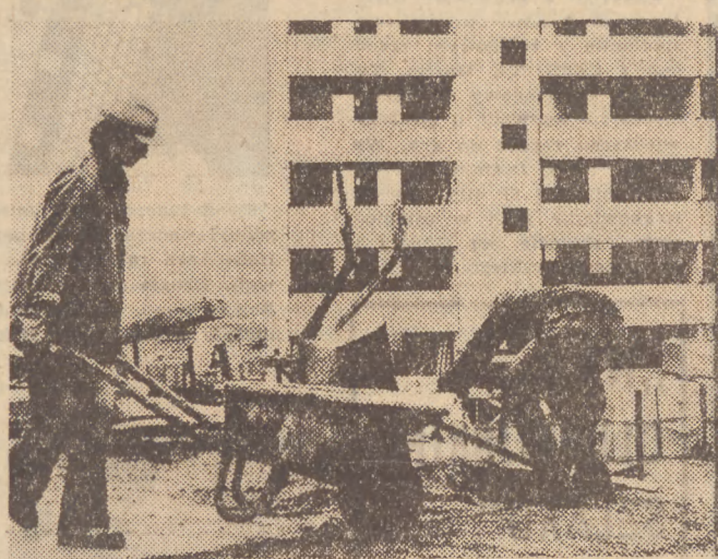
Na budowie słupskiego osiedla mieszkaniowego Westerplatte budowlani zajęci są m. in. pracami wykończeniowymi drugiego skrzydła obiektu, przeznaczonego na przedszkole.
