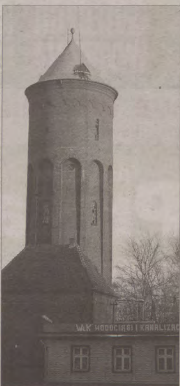
Początek obwodnicy będzie za budynkami Miejskiego Przedsiębiorstwa Wodociągów i Kanalizacji. Konkretnie na pobliskich łąkach. Fot. M. Pietrasz
