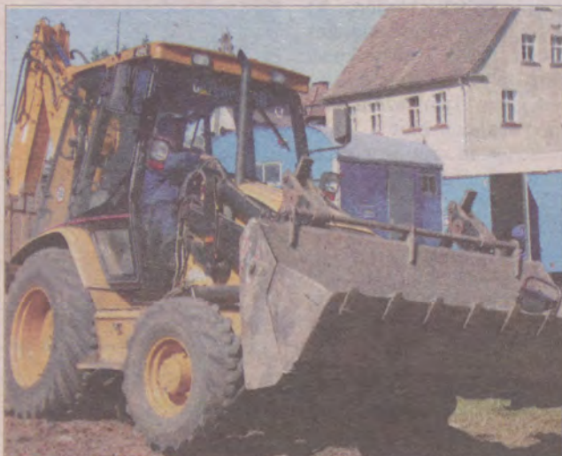
Plac budowlany został ogrodzony i wjechały na niego koparki. Tak rozpoczęła się budowa supermarketu. Fot. M. Pietrasz
