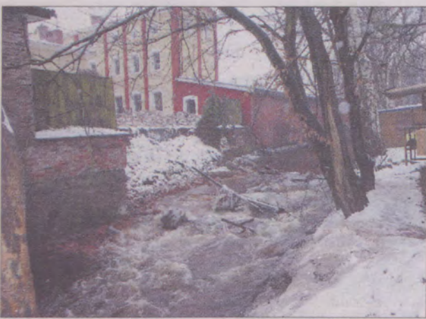
Taka kaskada w centrum Sławna to atrakcja czy szkoda?
