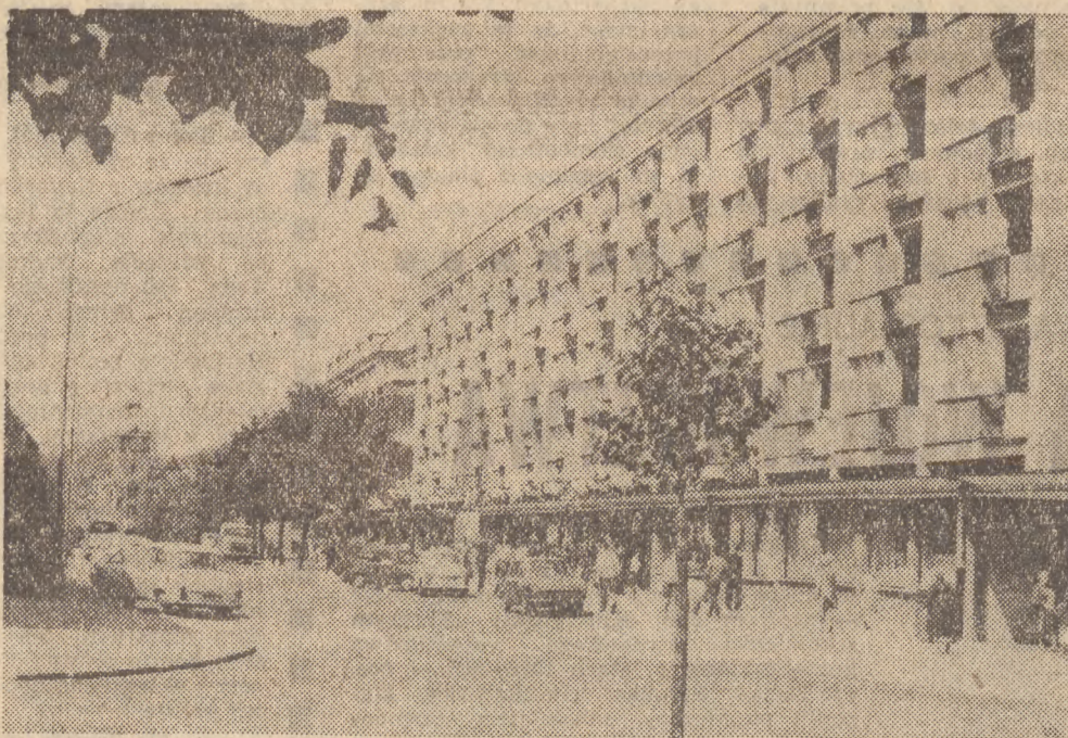
Na zdjęciu: budynek mieszkalny w Słupsku, przy alei Zawadzkiego wybudowany przez SPB.
