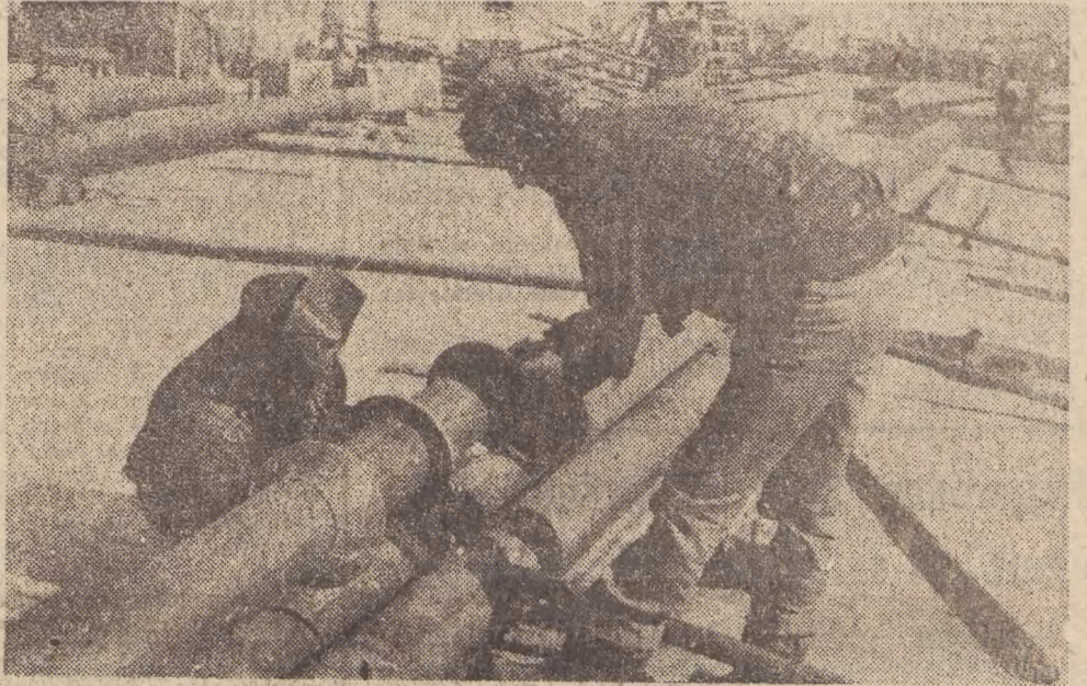
Monterzy Kotła Ufiskiego Przedsiębiorstwa Instalacji Budowlanych przy spawaniu słupów nośnych do lamp ulicznych. Fot. J. Piątkowski
