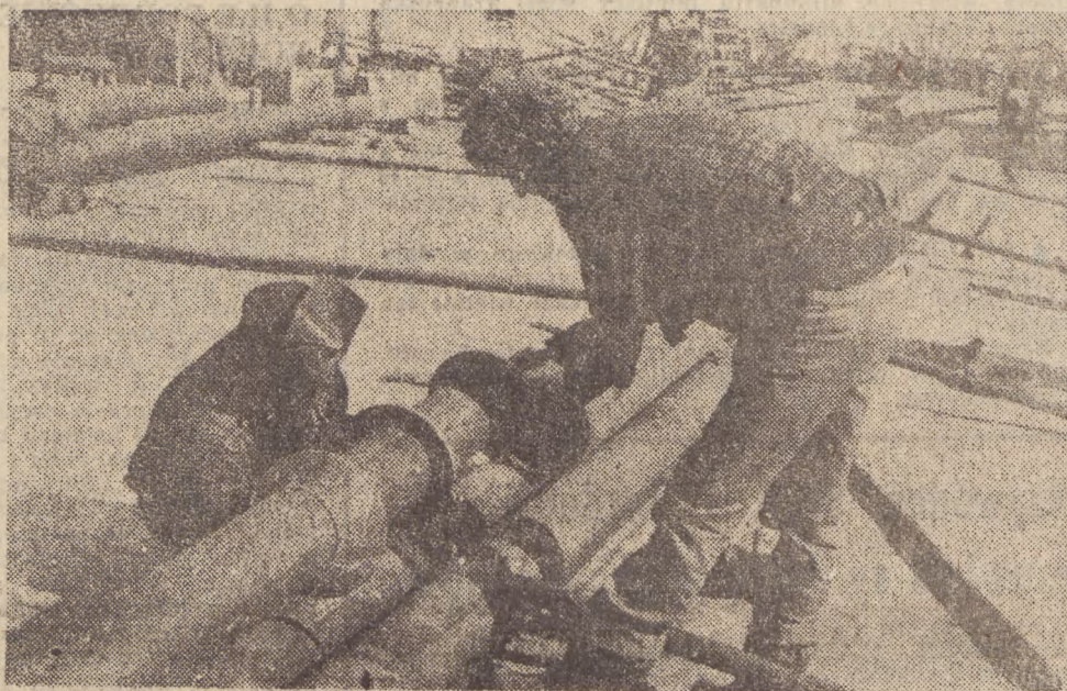
Monterzy Koszalińskiego Przedsiębiorstwa Instalacji Budowlanych przy spawaniu słupów nośnych do lamp ulicznych. Fot. J. Piątkowski
