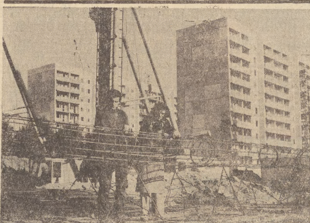
W rozbudowywującym się Kołobrzegu trwają roboty budowlane na osiedlu Im. Emili Gierczak. Obecnie Przedsiębiorstwo Robót Inżynierskich wibja 248 pali pod następny wieżowiec.
