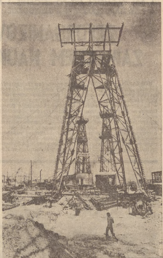
W Lubelskim Zagłębiu Węglowym trwa budowa kopalni w Bogdanie. Ostatnio przybyły tu nowe elementy świadczące o rozmachu inwestycji. Już z daleka widać dominującą nad okolicą wieżę wydobywczą. Po stawieniu na specjalnych szynach zostanie nasunięta na szyb po zakończeniu prac mrożeńiowych.
