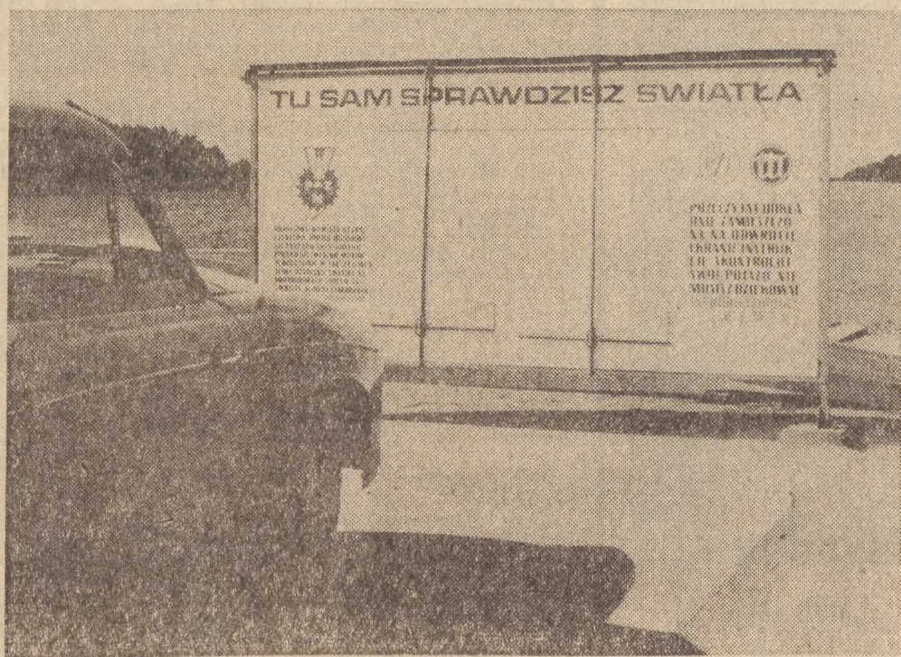
Każdy ze zmotoryzowanych, który zawitał do zajazdu „Hubertus” leżącego nie opodal Koszalin przy drodze na Szczecin, może sam skontrolować i ustawić światła swojego pojazdu. Służące do tego celu proste urządzenie zostało w tych dniach oddane do użytku.
