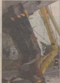
4 maja dźwиг uszkodził wiadukt przy ul. Armii Krajowej. Przez żmudne procedury przetargowe nadal nie rozpoczął się jego remont.
