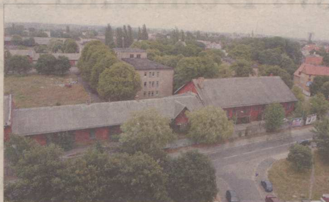
Koszary przy ul. Słowackiego w centrum Wrzeszcza. Już czas, żeby postanowić coś o przyszłości tego miejsca.
