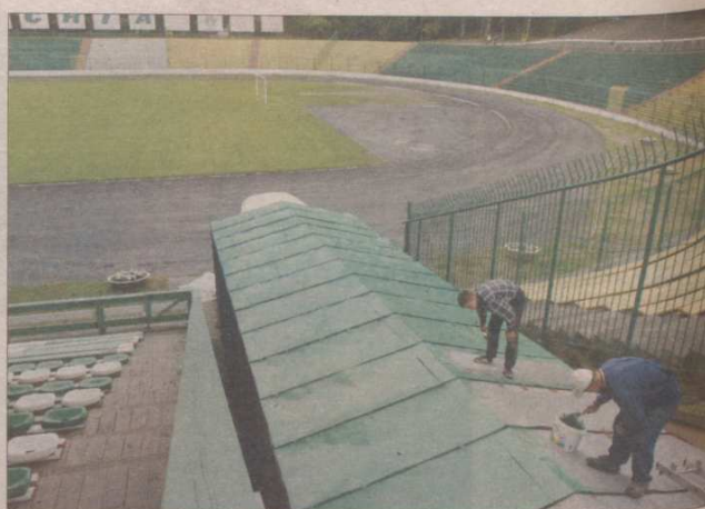
Wczoraj na stadionie przy Traugutta zajmowano się tunelem. Fot. Adam Wierzbny
