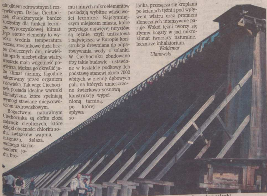
Łąka to unikatowa i największa w Europie konstrukcja drewniana do odparowywania wody z solanki.
