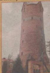
Wieża ciśnień w Miastku.
