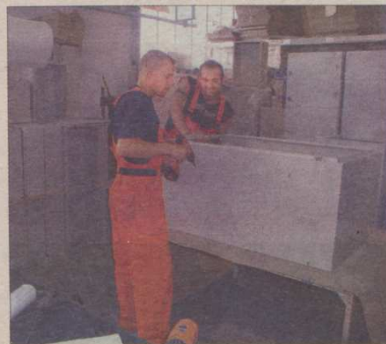
Ryszard Parka i Piotr Czaja, pracownicy Radioleksu podczas montowania metalowej obudowy.
