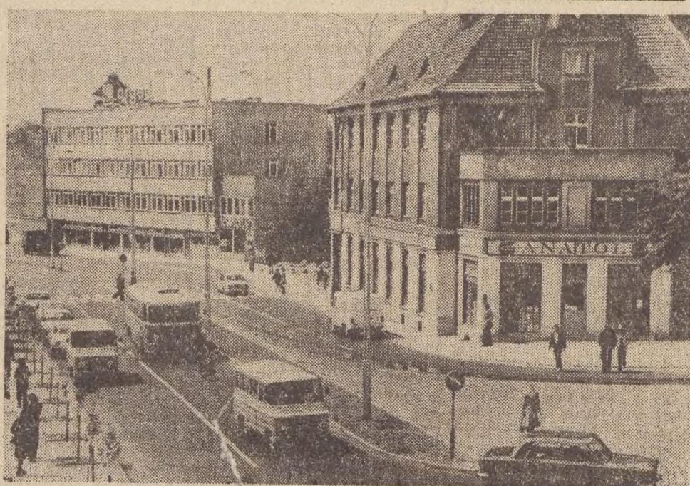
KOSZALIN. Trwają prace przy przebudowie przelotowych ulic. Od ubiegłego tygodnia poszczególne odcinki budowlani — drogowcy oddają już do użytku. W ubiegły piątek otwarto gruntownie przebudowany i znacznie poszerzony odcinek ulicy Zwycięstwa pomiędzy hlo>mi Jana s Kolna i Przydworcowa.
