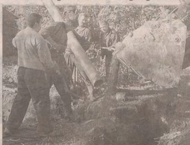
Trwają prace przy budowaniu kanalizacji w Starym Polu. Na zdjęciu (od lewej) Edward Podjaski, Mariusz Ossowski, Marek Fic i Kazimierz Łomacki.
