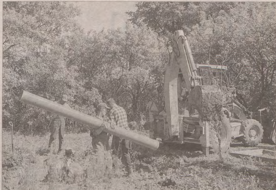
Prace przy budowie kanalizacji we wsi Stara Wisła. Na zdjęciu na pierwszym planie Władysław Świącichowski.
