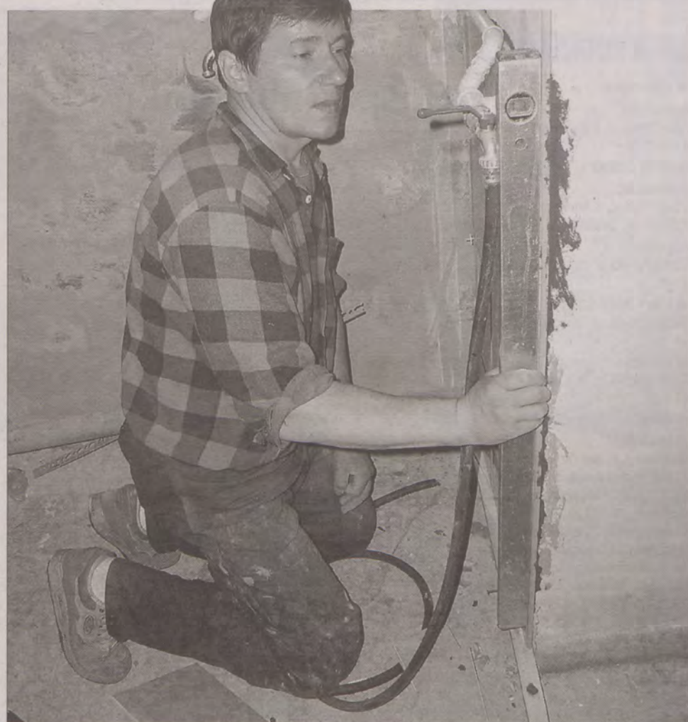
Ireneusz Kmiecinski kładzie kafelki w pomieszczeniach kuchennych Przedszkola nr 5.
