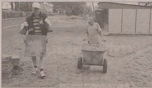
Trwają prace przy budowie chodnika. Na zdjęciu (od lewej) Bronisław Kopecki i Zygmunt Damaske. Fot. Henryk Jankowski
