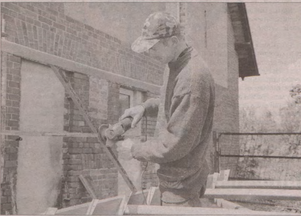
Paweł Jabłoński szlifuje schody, które będą zamontowane w budynku świetlicy.
