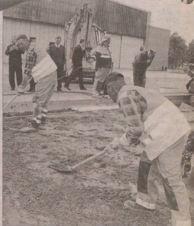
Lotnisko w Królewku Malborskim to wielki plac budowy. Pracują na nim fachowcy z 21 firm.
