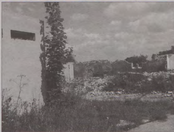
Z opuszczonego budynku stolarni w Czarnem Dolnym ukradziono już drzwi, okna, cegły...
