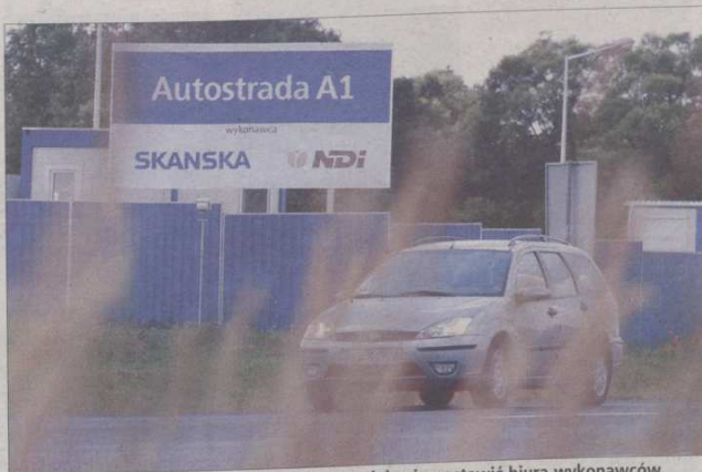
Na razie na terenie budowy autostrady A-1 udało się postawić biura wykonawców.
