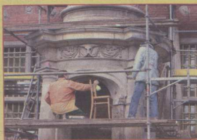
Nawet największy upał nie zwalnia od ciężkich prac remontowych.
