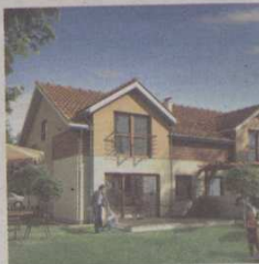
Osiedle domów jednorodzinnych Nowiec Gdańsk, ul. Dolne Młyny
