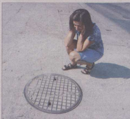
Na ulicach i w domach osowian zaczęło śmierdzieć, gdy półtora roku temu do biegnącej przez osiedle kanalizacji podłączono kolektor zbierający ścieki z pobliskiego Żukowa i Chwaszczyna.
