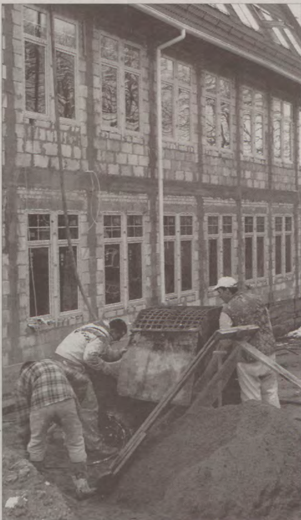
Główną inwestycją oświatową w przyszłorocznym roku będzie dokończenie budowy ZSER w Bytowie.
