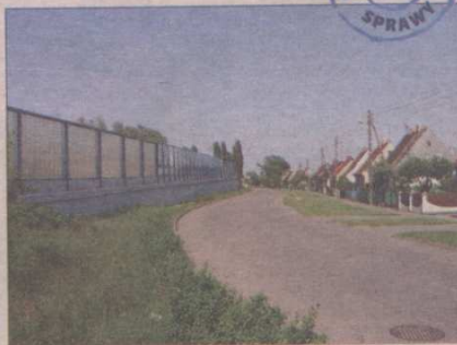
Ekran dźwiękochłonny na osiedlu Rudniki.
