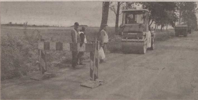
Drogowcy na trasie łączącej Łebcz z Władysławowem uwinęli się w ciągu kilku dni z remontem nawierzchni.
