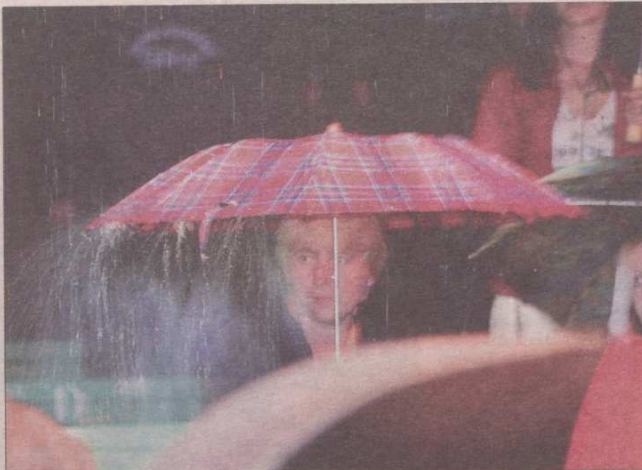
O tym, że dach Opery Leśnej przecieka, najlepiej wie publiczność.
