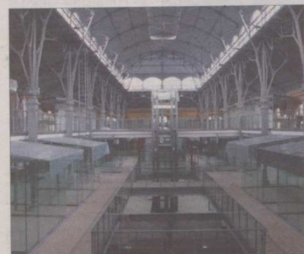
Jeszcze tylko ścianki działowe i kupcy przystąpią do handlowania.
