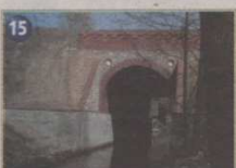
15. Fojutowo. Akwedukt w Fojutowie to najdłuższa budowla tego typu w Polsce. Liczy 75 m.
