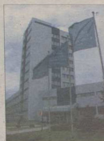
Tak wygląda portowy biurowiec w Gdyni po odnowieniu.
