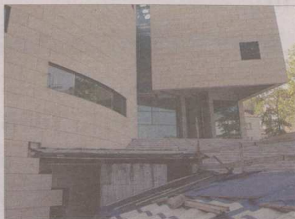
Na placu budowy Muzeum Marynarki Wojennej i Miasta Gdyni dziś niewiele się dzieje.
