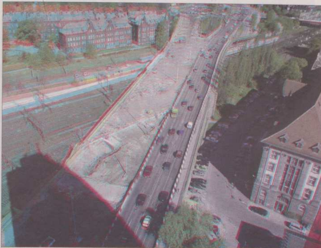
Rok 2005. Remont Błędnika... Znowu jeździmy tylko jedną stroną wiaduktu nad torami kolejowymi.
