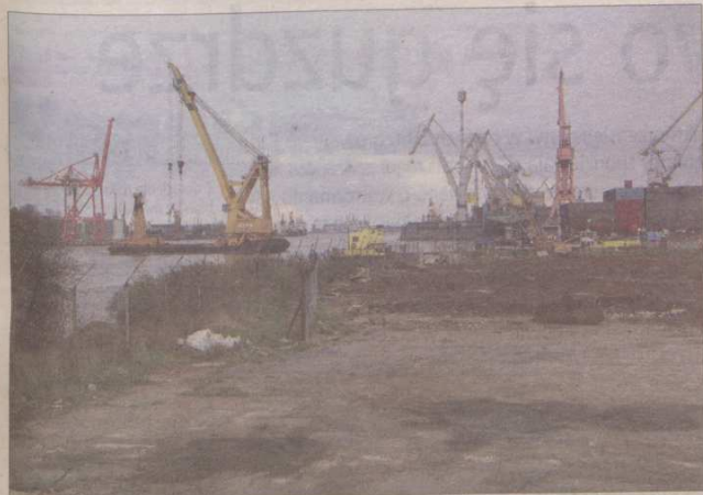
Na placu budowy przyszłego terminalu kontenerowego Gdynia Container Terminal SA GCT w porcie gdynskim konczy się wyburzanie starej zabudowy.
