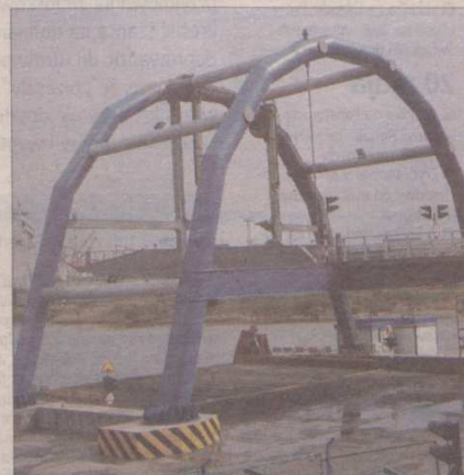
Gotowa jest już dwupoziomowa rampa przeładunkowa ro – ro dla promów pasażersko-samochodowych szwedzkiego armatora Stena Line w terminalu promowym portu gdynskiego.
