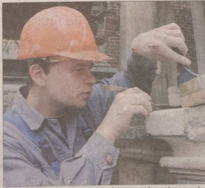
Cezary Rek, konserwator zabytków pracuje nad przywróceniem świetności Wielkiej Zbrojowni.
