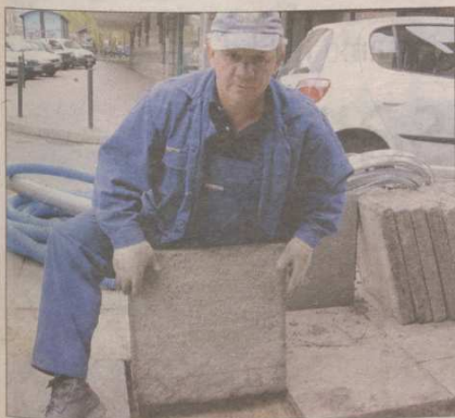
Ryszard Bigus, uклада chodnik przy ul. Elżbietańskiej.
