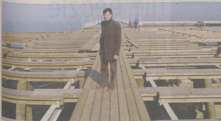
Usunięto zniszczone deski, z wody wyciągano przegniłe pale. - Jak zepsute zęby - śmieje się Krzysztof Małasiewicz.
