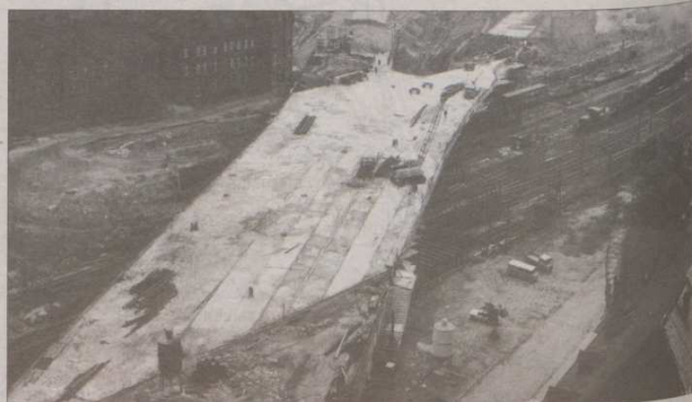
Błędnik budowano w latach 1967-1970. Po 25 latach, czeka nas półtora roku remontu wiaduktu.
